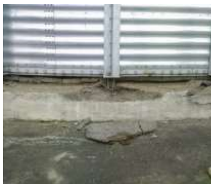
Сурет 2. Силосты пайдалану объектілерінің ақаулы орнатылуы
