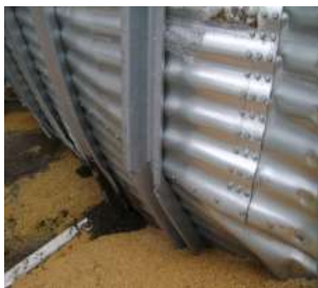
Сурет 1. Силостардың деформациясы
